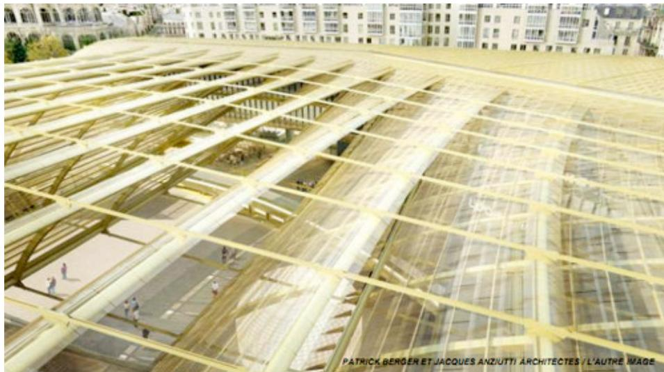
*La nouvelle version de la Canopée, à présent découpée en tranches et soutenue par des armatures en métal*
